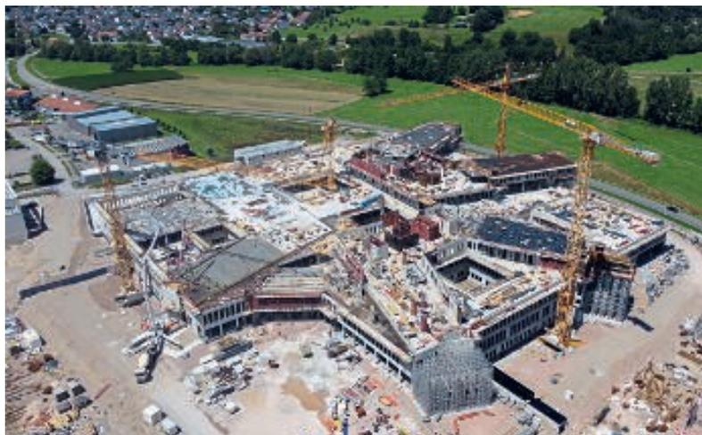
Die Sockelgeschosse sind in einem Raster von 7,50 Meter mal 7,50 Meter konzipiert. Das ermöglicht eine problemlose Umnutzung der Räumlichkeiten.
